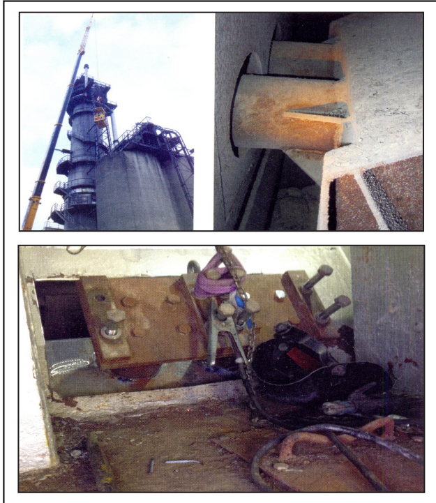
شکل ۱۱- خرابی ناودانی اولیه کوره آهک در کارخانه Clouen
