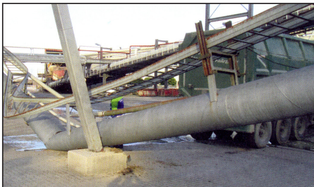
شکل ۱۲- آسیب وارد شدن به لوله توسط کامیون در کارخانه Nordstemmen
